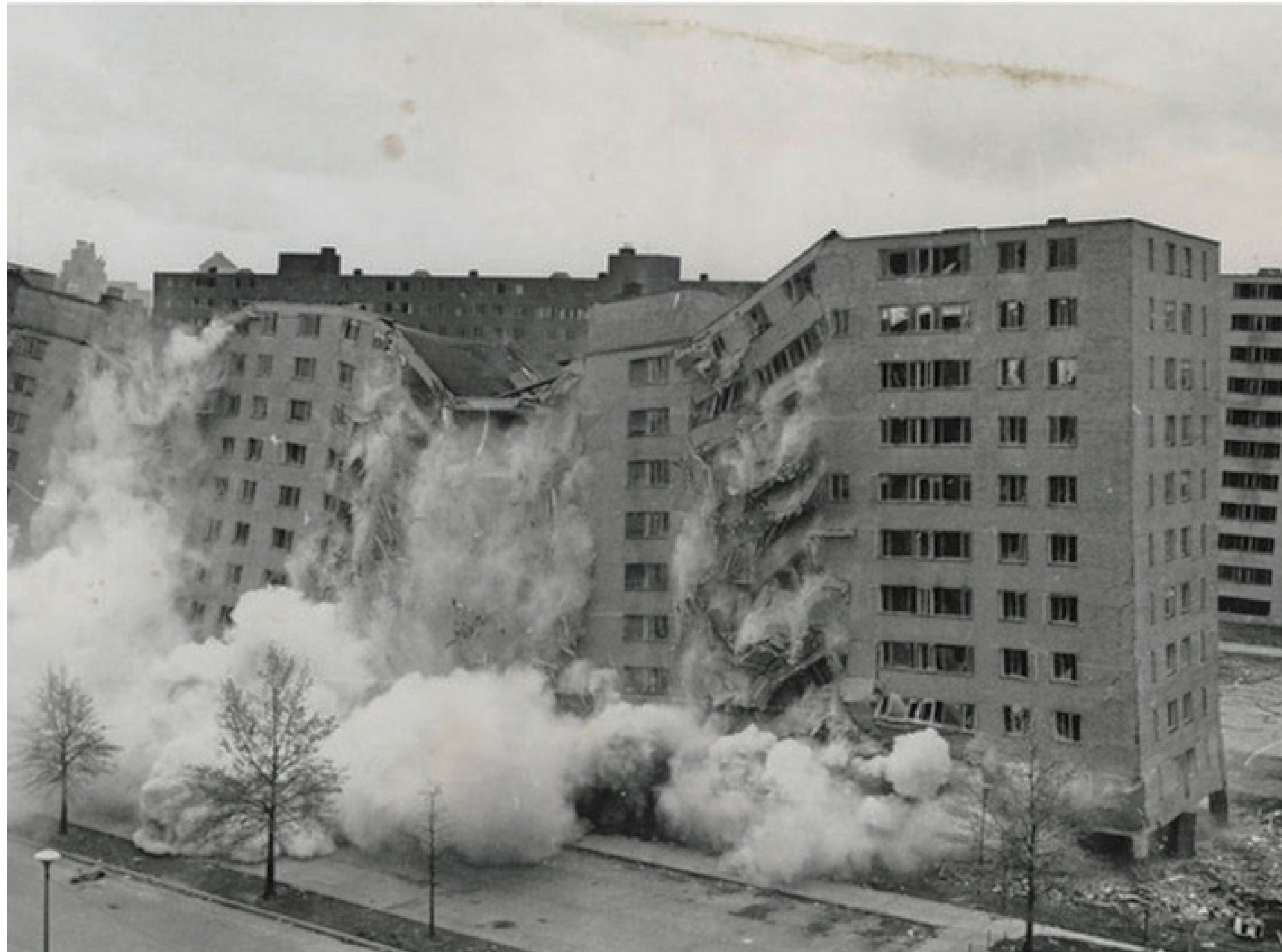
Démolition quartier Pruitt-Igoe, St-Louis, 1972
