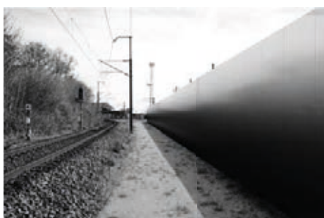
Poste d'aiguillage - agence titan, Nantes en cours
