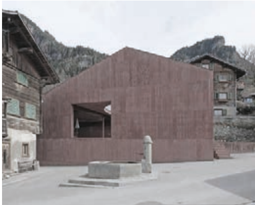
fig. 7 : Christian Kerez (+ Joseph Schwartz ingénieur), HOUSE WITH A MISSING COLUMN, Zurich (Suisse), 2014- Plan R+2 + photo extérieure + intérieure - Charges verticales reprises par trois colonnes périphériques (ascenseur, escalier, gaines)
