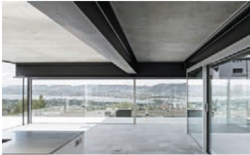
fig. 7 : Christian Kerez (+ Joseph Schwartz ingénieur), HOUSE WITH A MISSING COLUMN, Zurich (Suisse), 2014- Plan R+2 + photo extérieure + intérieure - Charges verticales reprises par trois colonnes périphériques (ascenseur, escalier, gaines)
